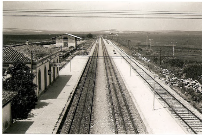
Figura 3. Estación de El Cuervo de Sevilla, muelle cubierto y descubierto. Vista sobre paso sobre elevado en sentido Lebrija. Fecha: 1970. Archivo: Pedro Pajares.
